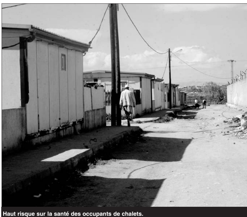
Haut risque sur la santé des occupants de chalets.
